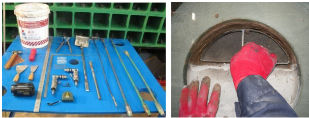
图8 施工模拟工艺与设备
