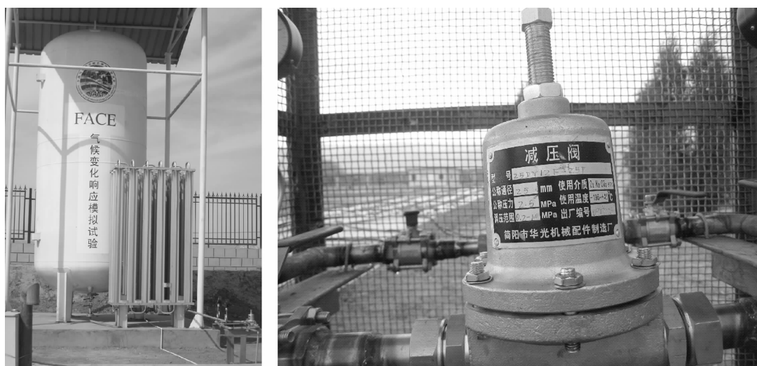
图2 FACE平台供气装置(罐体、气化器、减压阀)
