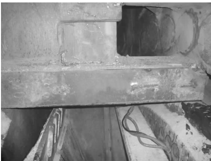
(a) 修复后的碴仓主筋板
