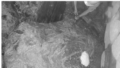
图 10 爆破刀盘前方岩石
