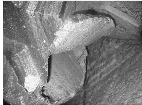
(b) 碴仓入口冲击挤压破损
