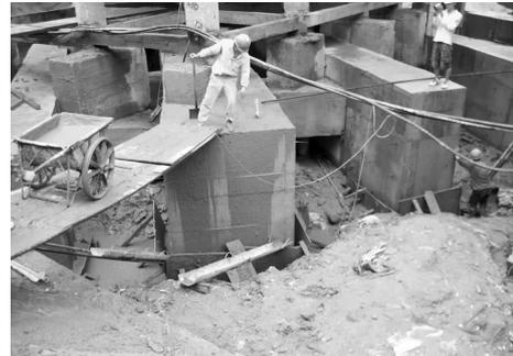
图12 膨胀混凝土封桩
