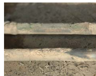
图 6 风冷管(上)、水冷管(下)积灰情况
