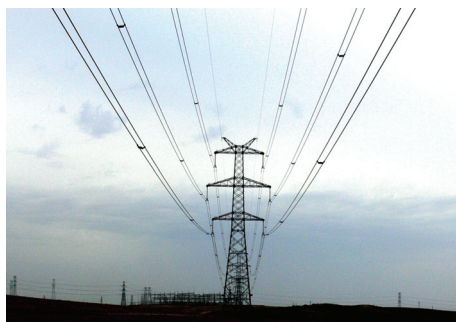
图 3 330 kV 同塔双回线照片
