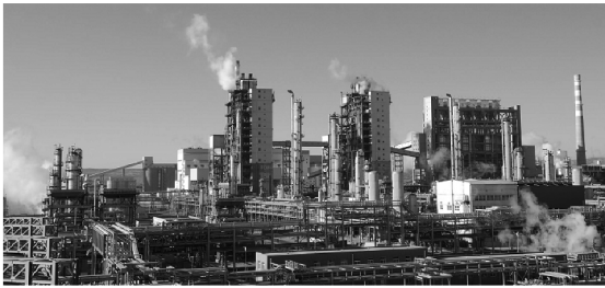
图 2 神华集团煤直接液化示范工程装置
