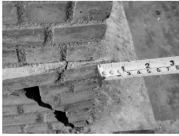
图 11 墙角扭转滑移
