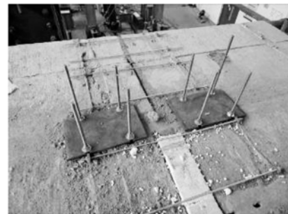
图6 屋面张拉垫板 Fig. 6 Plate on roof
