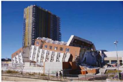
图 4 钢筋混凝土剪力墙结构的倒塌 [3]
