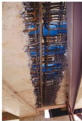
图 11 连体部位的破坏 [4]
