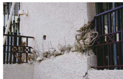
(b) 某剪力墙根部破坏
