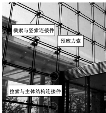
图3 单层平面索网结构组成示意图 Fig.3 Components of a single-layer plane cable net
