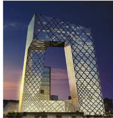
图 3 CCTV 新办公楼工程
