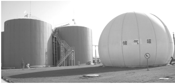
图 4 蒙牛澳亚示范牧场大型沼气发电综合利用工程 Fig.4 Large-scale biogas engineering at Mengniu-Macao Demonstration Pasture
