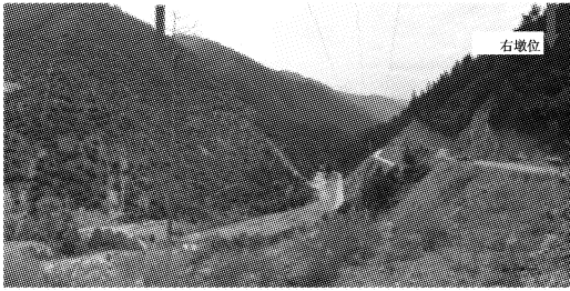
(a) 桥位岸坡
