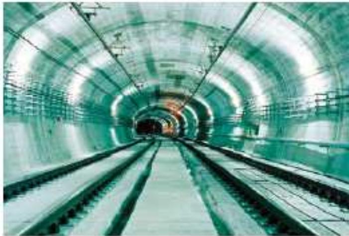
图 2 广州地铁 2 号线采用刚性接触网
