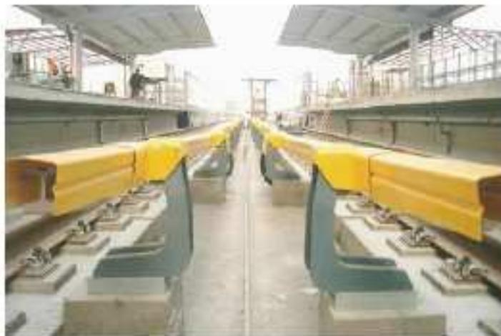
图 3 广州地铁 4 号线采用接触轨
