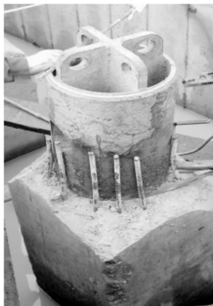
图 1 锁口管与桩顶焊接
