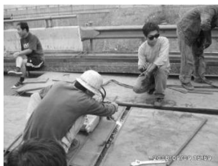
图 9 焊接坡口开设
