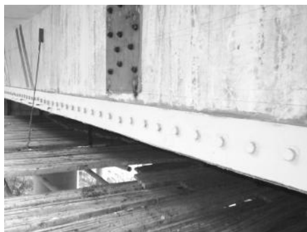
图 19 桥梁加固钢板的焊接接长
