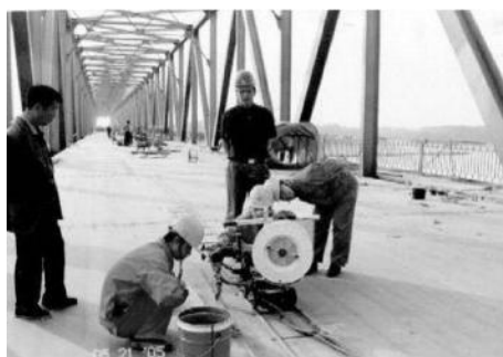
图 3 桥面板埋弧自动焊盖面
