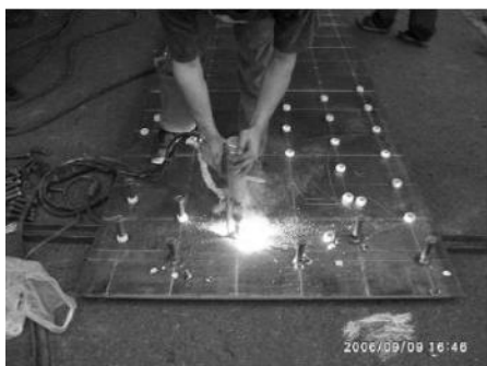
图 6 盖梁板螺柱焊接
