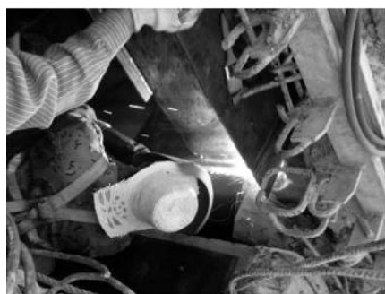
图 16 伸缩装置下端加固构件的焊接
