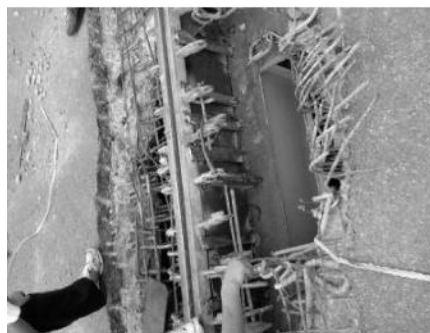
图 17 伸缩装置加固构件的焊后状况
