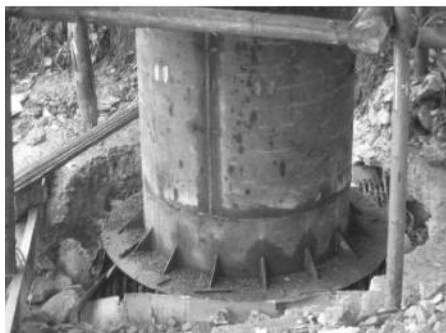
图 13 焊接新增钢护筒加固 2# 墩
