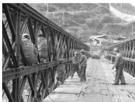
图 22 主桥加固即将结束的新桥线形
