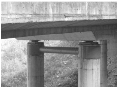
图 12 焊接新增横系梁加固 2# 墩
