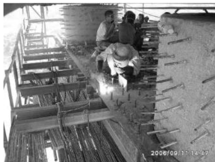
图 11 盖梁底板 CO 2 气体保护焊
