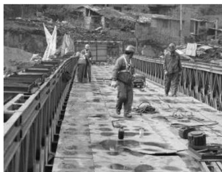
图 21 拆除旧桥相关的构件
