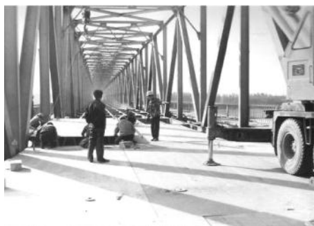
图 2 桥面正交异形板单元焊前组对
