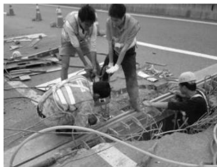
图 15 锚固件焊接
