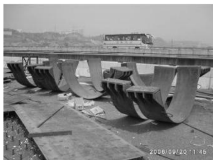
图 8 双柱抱箍牛腿支撑体系单元
