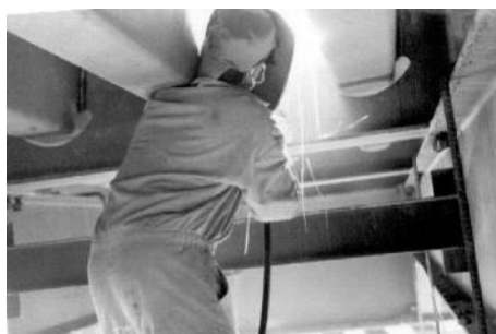
图 4 正交异性板单元与横梁支撑焊接
