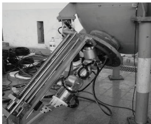
(a) 机器人安装
