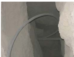
图 6 裂隙两端分别注浆
