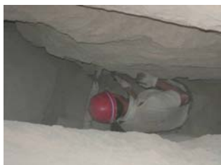
图 5 裂隙两侧锚孔封堵
