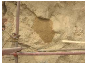
图 8 作旧完毕的锚孔
