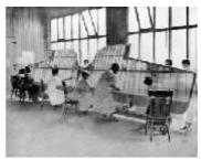
20世纪20年代,美国波音MB-3A飞机与波音波音公司MB-3A的机翼生产车间[资料]
