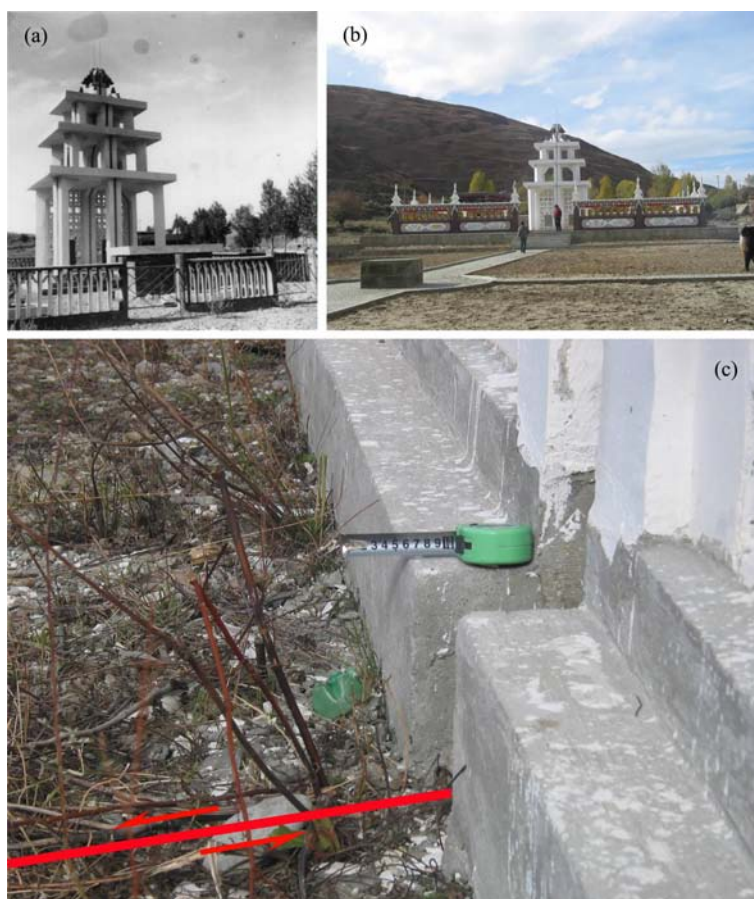
图 3 炉霍地震纪念碑亭及其震后位移的照片
