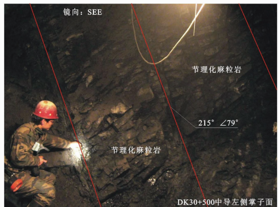
图5 掌子面上发育的构造挤压破碎带
