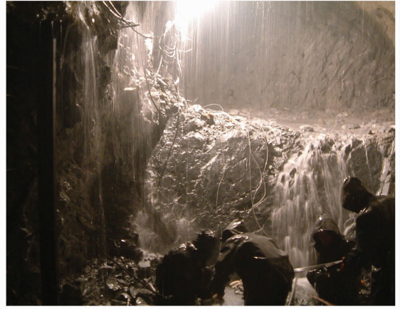
图4 旧堡隧道 ZD241 孔承压水及 2#斜井施工中的突发涌水
