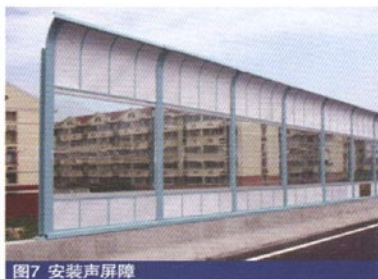
图7 安装声屏障
