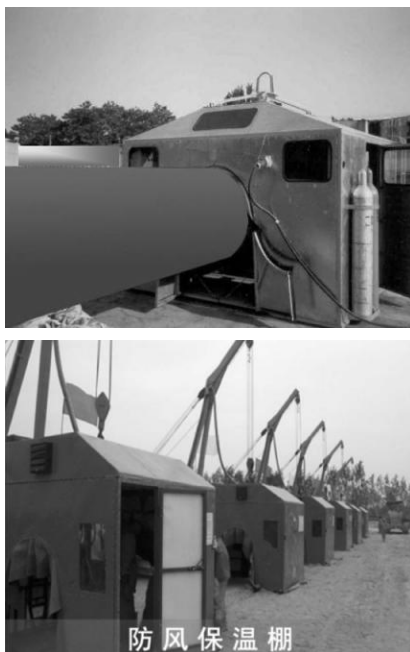
图 2 焊接防风保温棚
