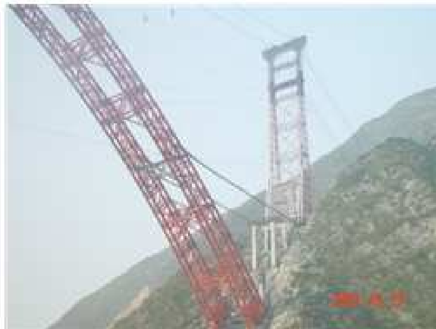
巫山长江大桥 塔架照片
