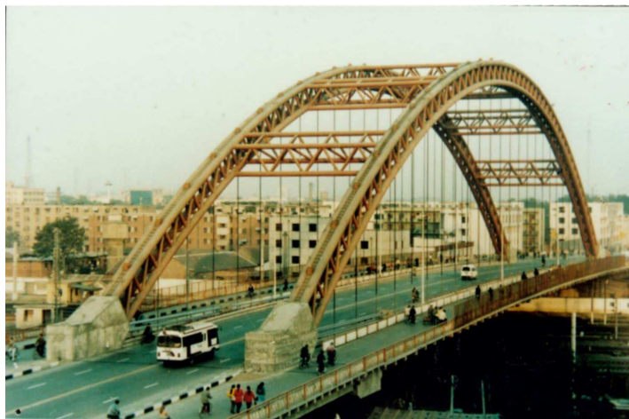
河南安阳文峰路立交桥
