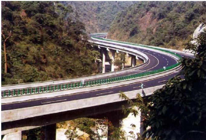
福建 漳龙高速公路上的弯梁桥
