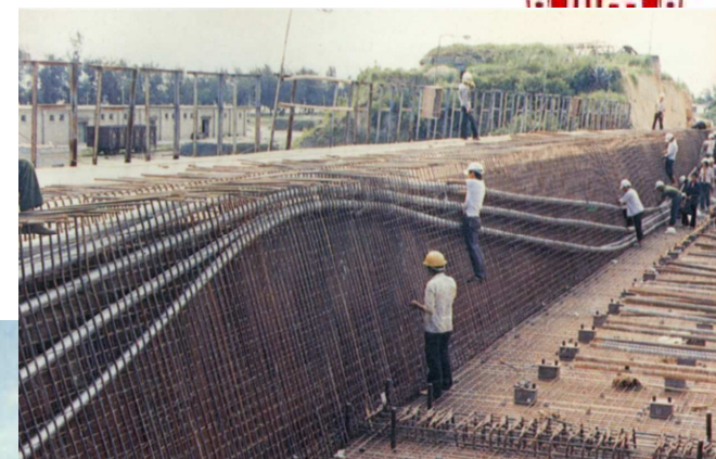
主桥箱梁钢束和钢筋布置
