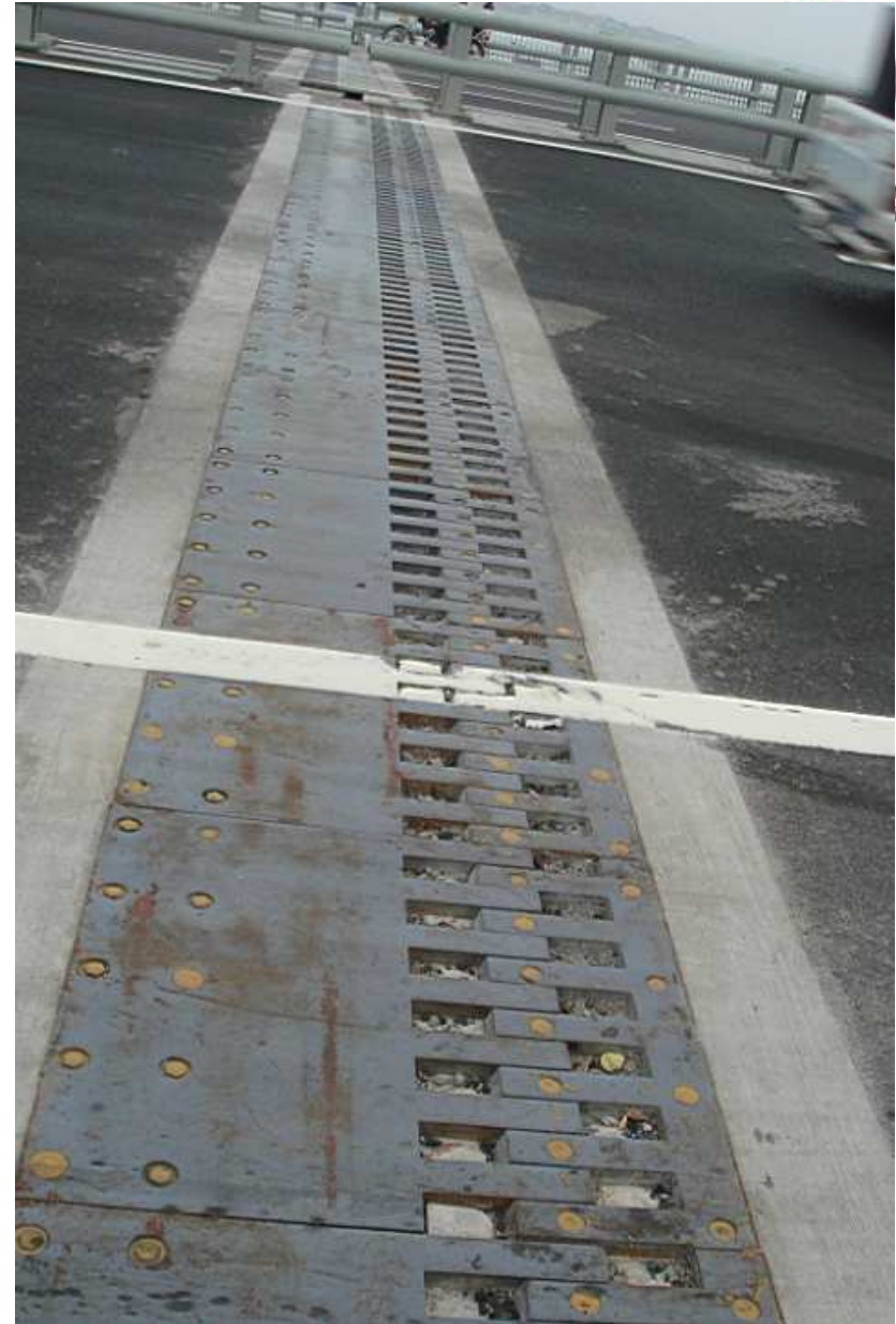
晋江大桥钢板伸缩装置
