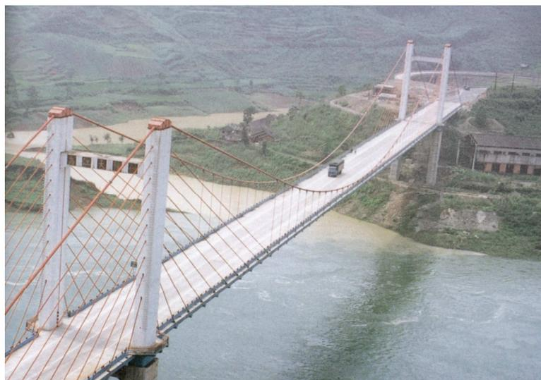
1997年建成的乌江大桥，主跨288m，主梁为高强预应力薄壁箱梁，采用全截面缆吊预应力悬拼施工，最大吊重为76吨，是世界首座吊拉组合桥。
