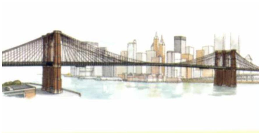
1883年建成的纽约布鲁克林大桥，主跨484m，是最早的带斜拉索的吊桥。
