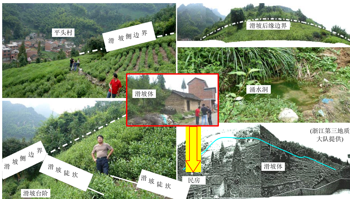
图 1 平头村山体高边坡灾害现状
