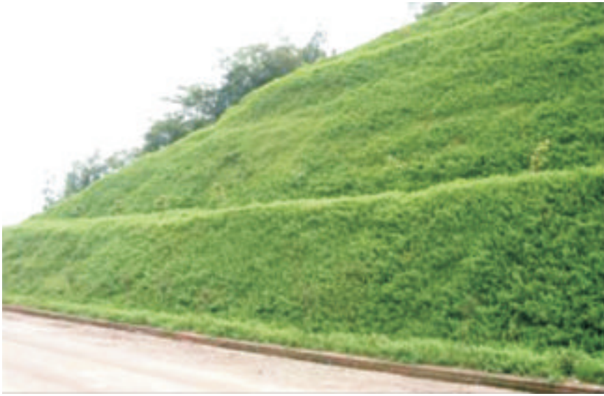
图4 道路边坡良好的地被可有效固土护坡
