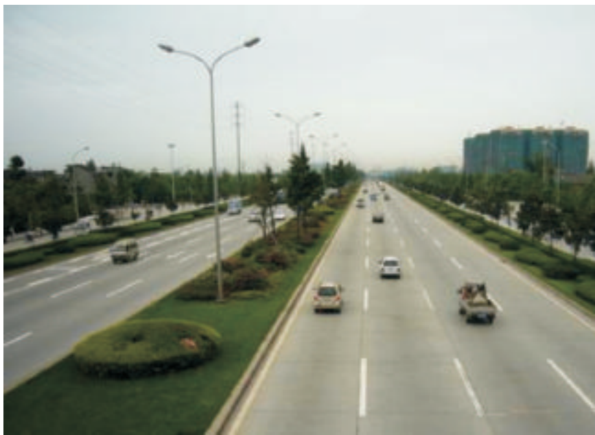
图1 道路绿化分隔道路空间
