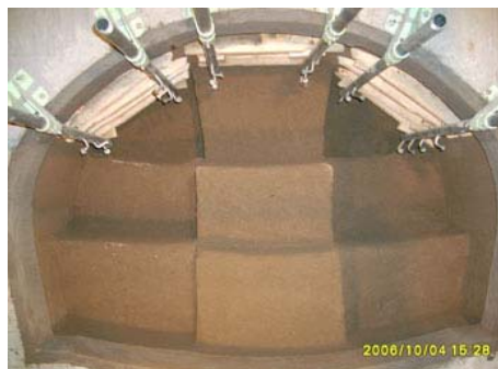
图 6 站厅隧道顺序开挖
