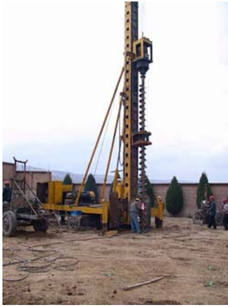
图2 成孔的长螺旋钻机
