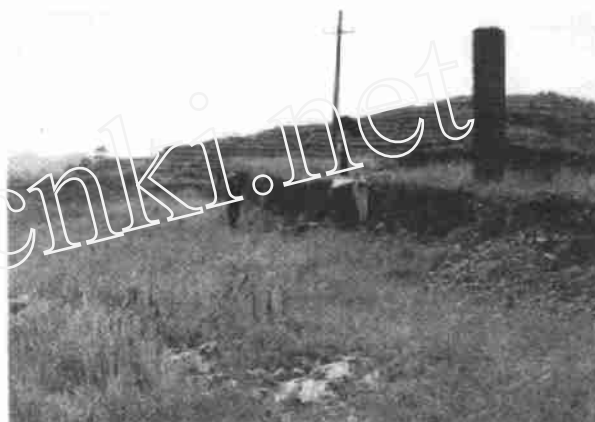
图 8 I 采区地表垂直错动变形
