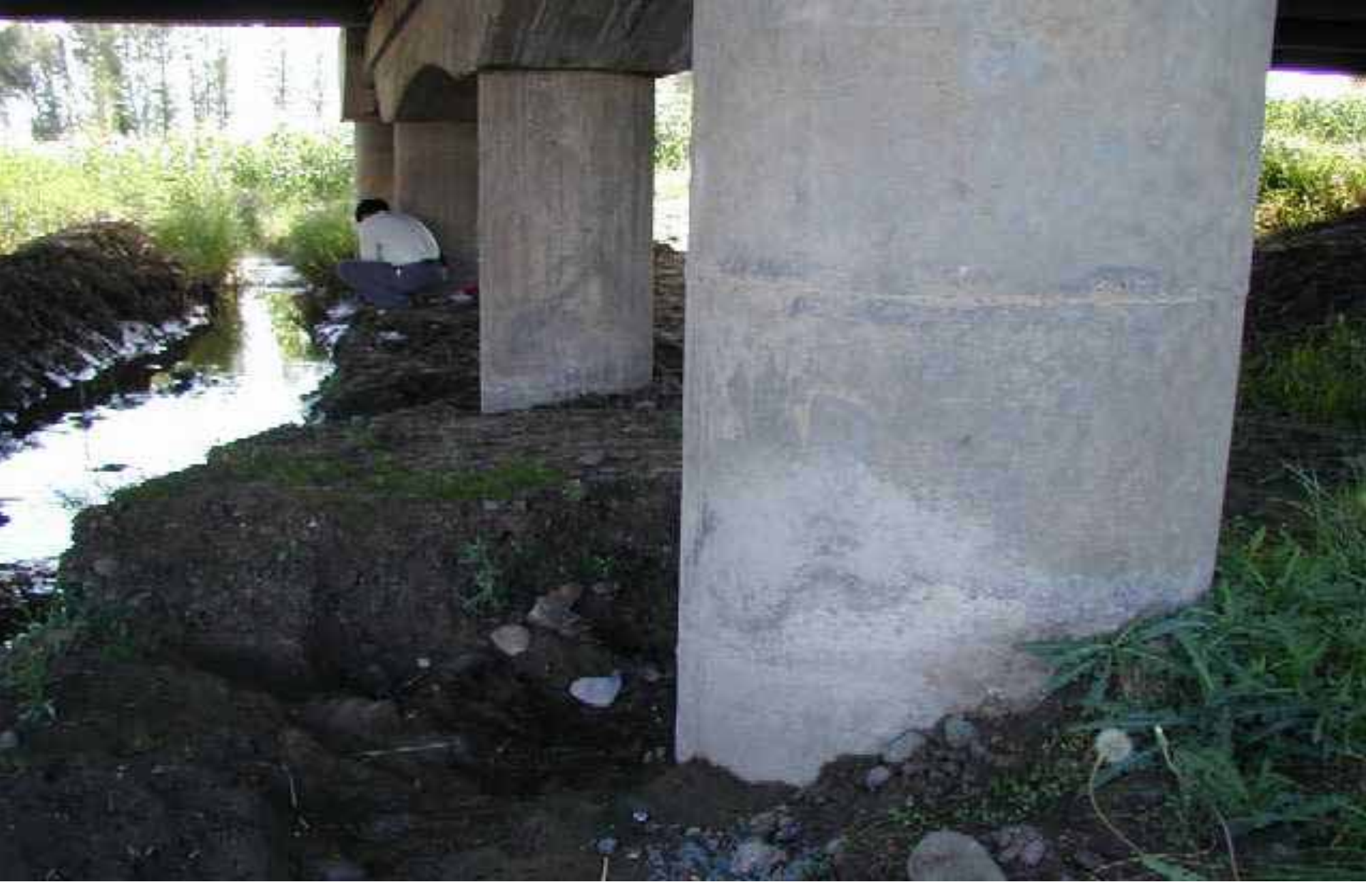
张掖—高架桥墩
