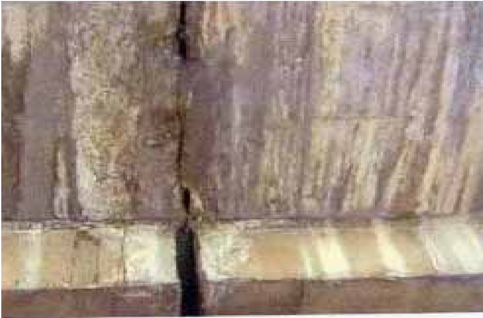
安定門橋懸臂析白
