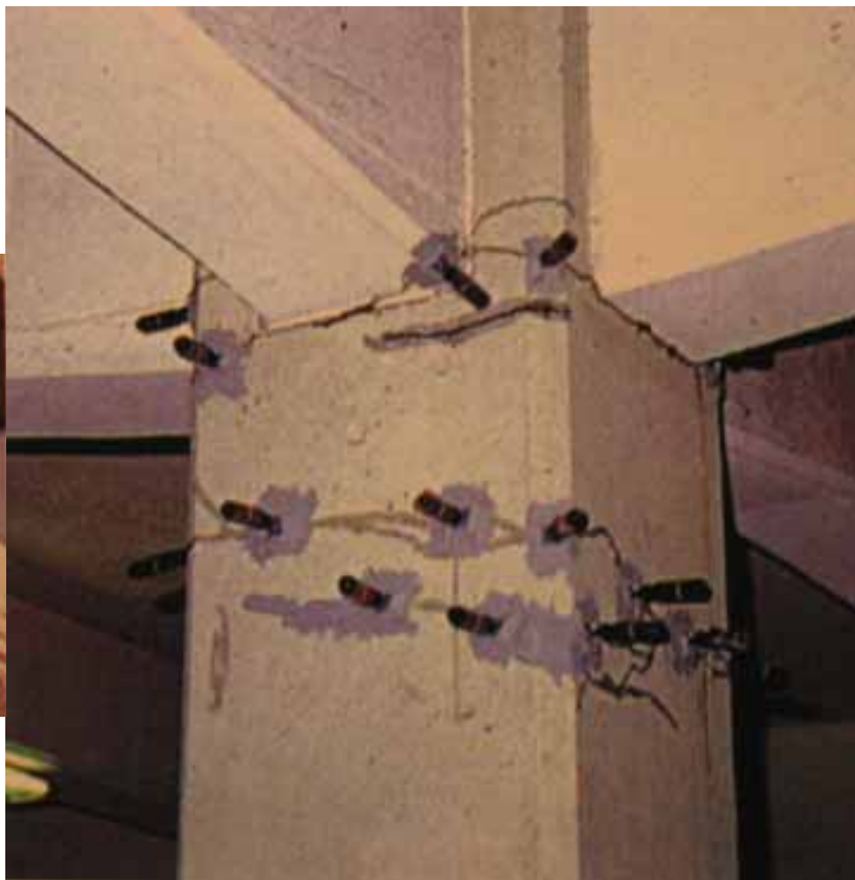
挤压环氧树脂修补裂缝
