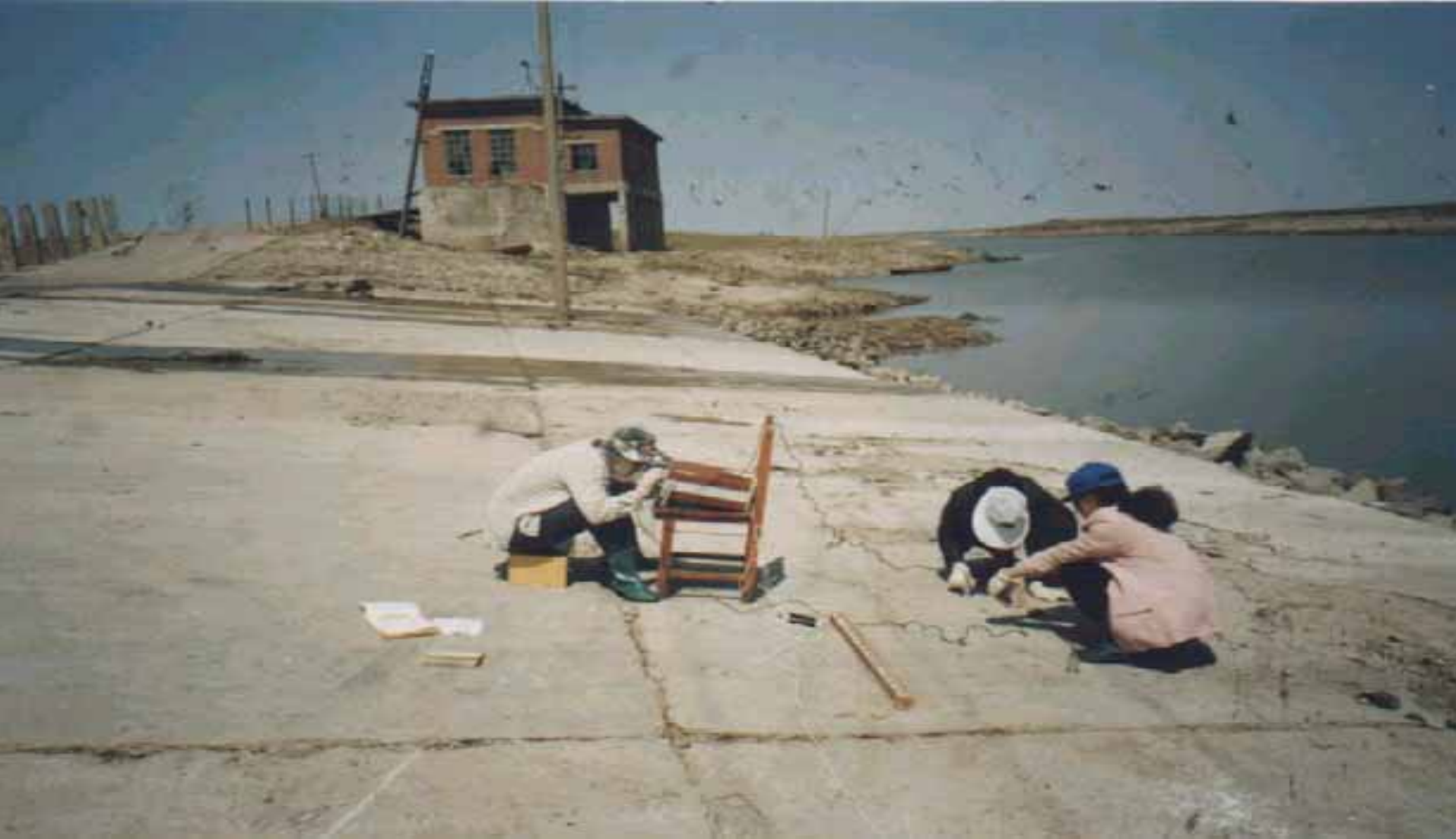
吉林省—某热电厂滚水坝混凝土 88年使用96年冻融破坏情况
