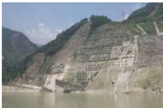
图 17 紫坪铺水利枢纽冲沙洞出口边坡支护效果比较
