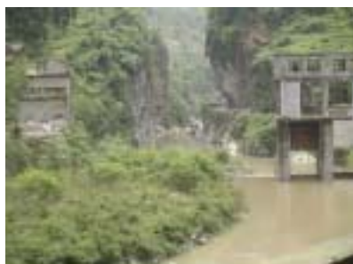
图 15 石亭江燕子岩滑坡坝(德阳市水利局提供)
