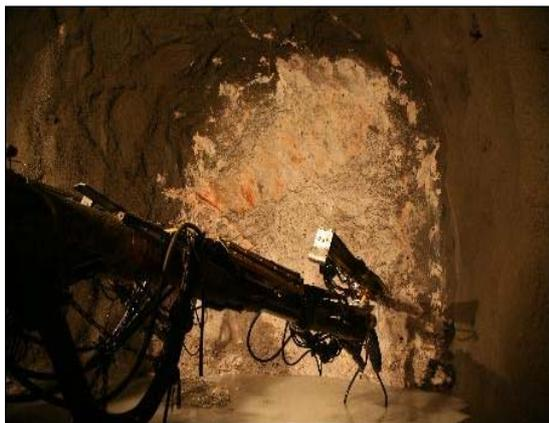
(b) 掌子面进行钻孔卸压施工
