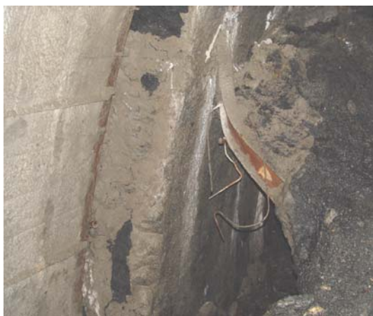
图 2 ZK104+783 初期支护大变形图
