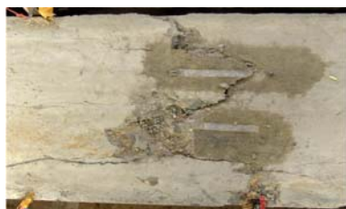
(a) 纯弯区段梁顶混凝土压碎情况
