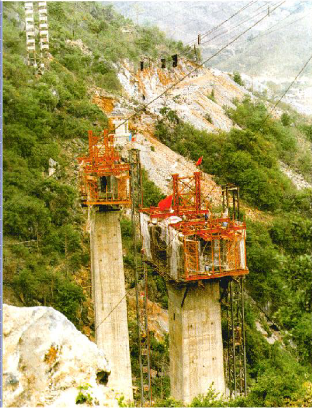
南昆铁路重点工程之一板其2号大桥依地形、顺山势,是中国第一座弯梁桥。
