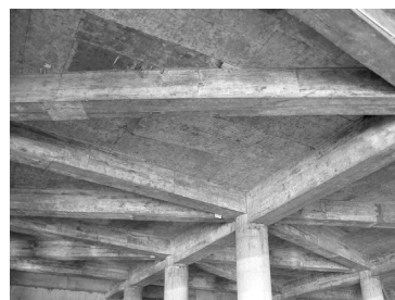
图 14 完好的横梁和桥面板 Fig 14 Well Beams and Bridge Decks
