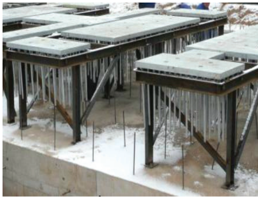
图 1 预埋件精确定位
