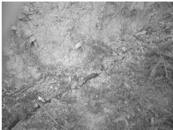
图 1 蛟岭隧道出口塌方段地表的裂缝
