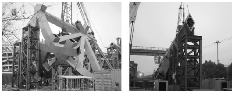
图 2 立柱上柱拼装
