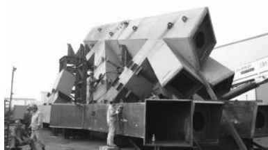
图 3 立柱下柱拼装
