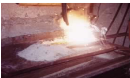
图 2 药芯焊带电渣堆焊过程照片
