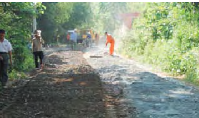
图3. 经过冷再生机搅拌过后的新的路基雏形
