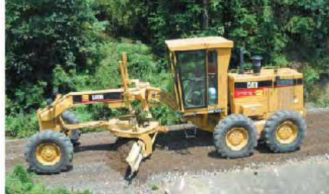
图4. 采用CAT140H平地机对新的路基进行整形和控制标高
