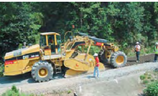
图2. 西郭线佐桥路段因骨料流失太多,先预铺新的骨料后再进行再生
