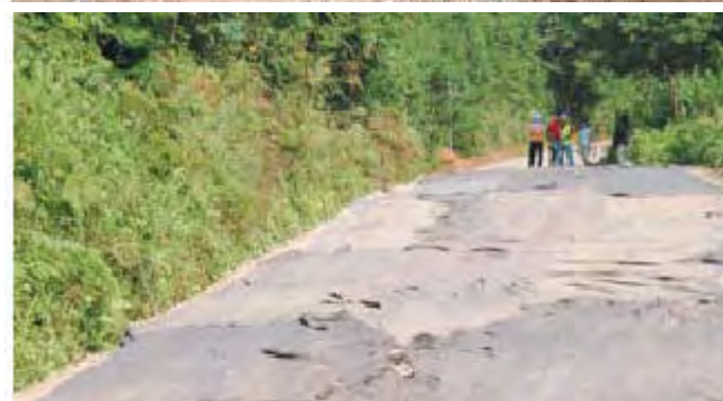
图6. 新路基在进行养生 养生后会在上面罩面,形成一条崭新的道路
