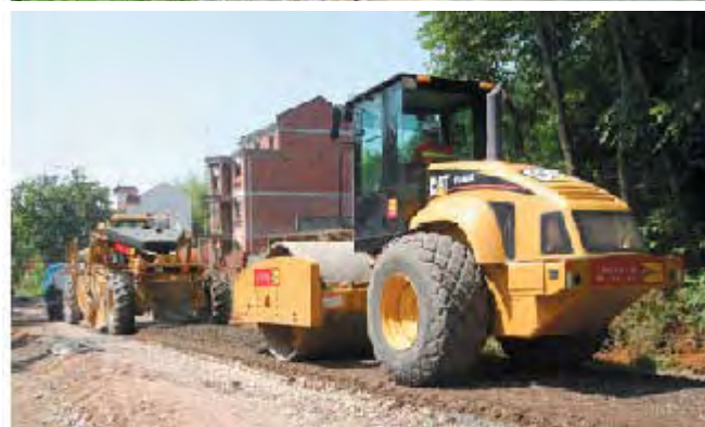
图5. 采用CATCS683压路机充分压实,保证压实度
