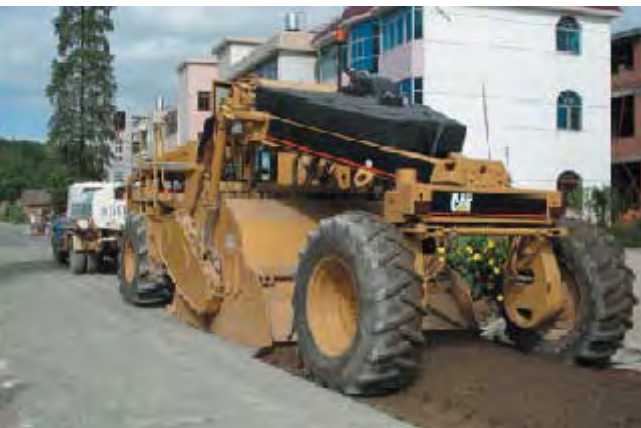
图1. RM300冷再生机接上水车,在已洒布水泥的原路面上进行搅拌再生
