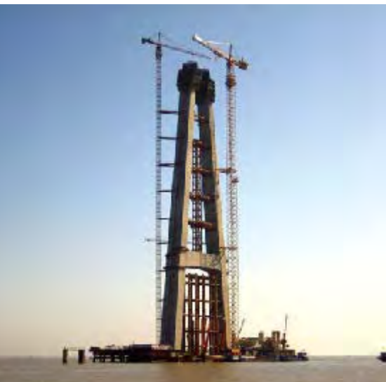
图2 塔机附墙整体现场照片
