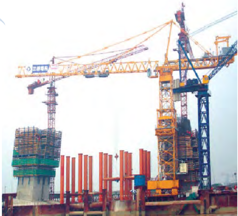
图1 起重臂安装完成后塔机雄姿
