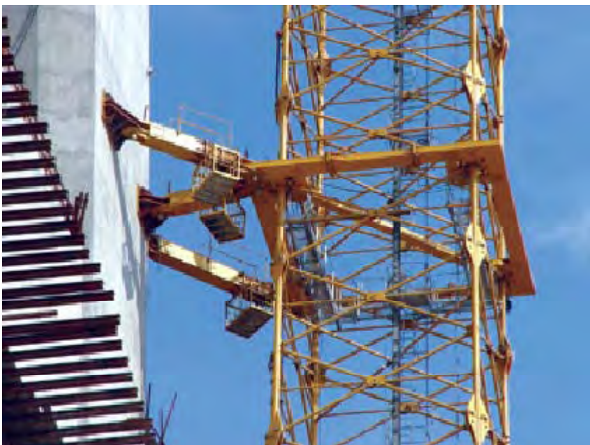
图9 塔机附墙局部现场照片
