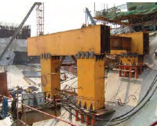
图5 基座安装完成后的照片
