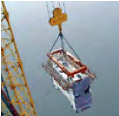
图8 吊装钢锚箱施工
