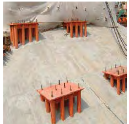
图4 基座预埋件安装完成后的照片
