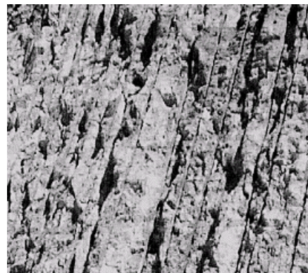
图 2 光面爆破效果图 Fig.2 Result of smooth blasting
