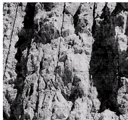
图 3 预裂爆破效果图 Fig.3 Result of pre-split blast
