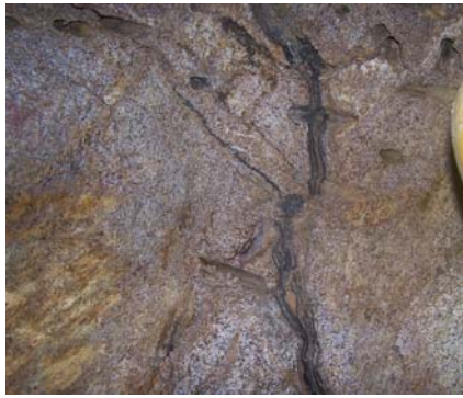
图 8 服务隧洞开挖面注浆效果
