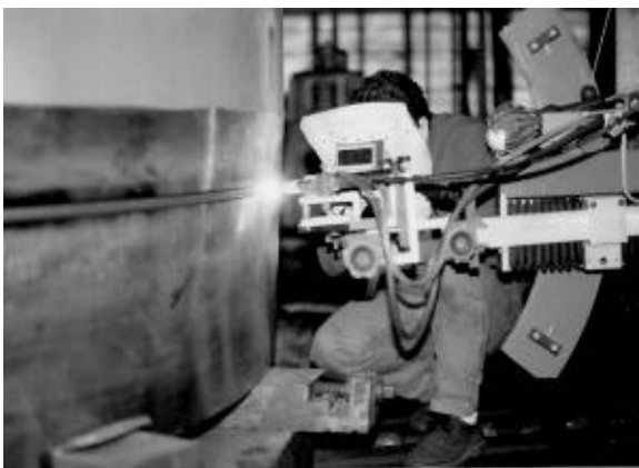
图 33 吊兰筒体与支承板焊接实况
